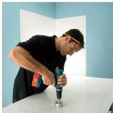
2. Perçage des arrivées d'eau
