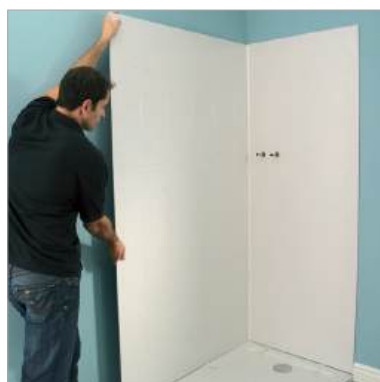
5. Pose des panneaux
