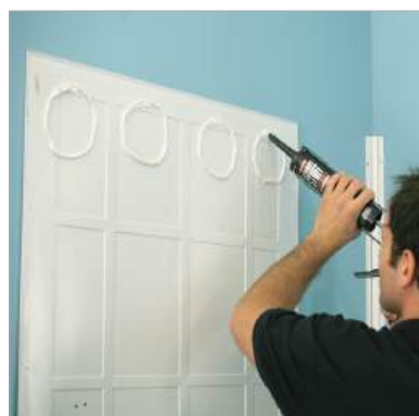
4. Encollage des panneaux au mastic-colle
