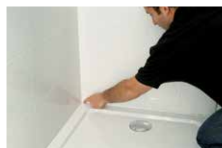
Pose d'un cordon silicone
