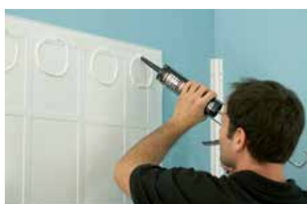
Encollage des panneaux au mastic colle
