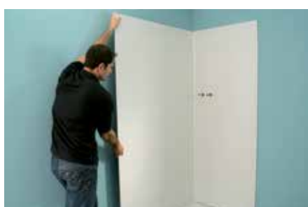
Pose des panneaux
