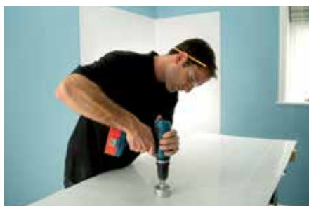
Perçage des arrivées d'eau
